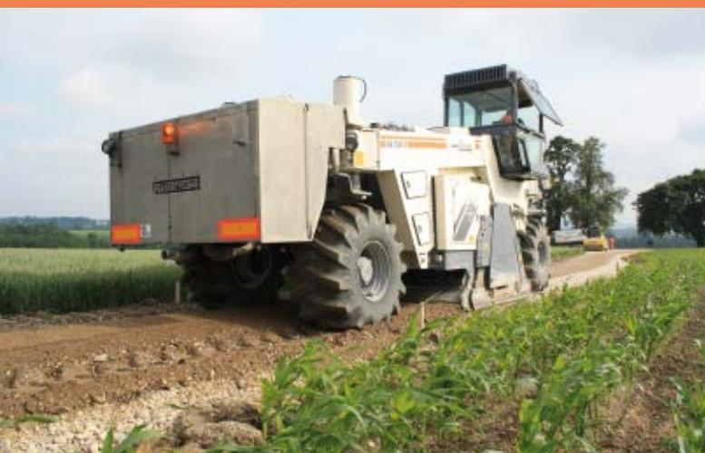
Ende Juni wurde der westliche Abschnitt des Güterweges Haidenheim vom Wegerhalteverband Hausruckviertel (WEV) neu asphaltiert. Auch der Unterbau wurde in einem neuartigen Verfahren (*Auffräsung der bestehenden Asphaltdecke, Vermischung mit aufgetragenem Schotter*) erneuert.
