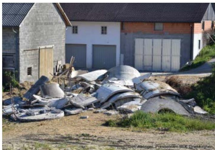
Ende August war der Sprengstützpunkt der FF Enzendorf beim Landwirt Martin Nöhammer, Rakesing 11 (*vulgo „Stari“*) im Einsatz. Auftrag war, die drei 10 m hohen Betonsilos dem Boden gleich zu machen.
