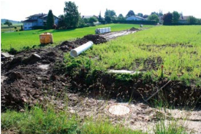
Im Zuge der Kanalbauarbeiten werden auch verschiedene Verkabelungen neu verlegt (*Straßenbeleuchtung, unterirdische Stromversorgung, Glasfaserleitungen*). Im Bereich der vom Kanalbau betroffenen „Kronlachner“-Baugründe werden auch die Wasserleitungen verlegt und anschließend der Tragkörper für die neuen – bzw. auf 6 m verbreiterten – Siedlungsstraßen hergestellt.
